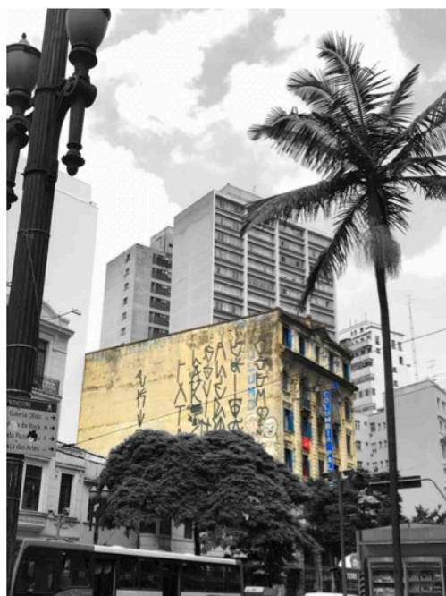
Figura 5: Prédio da Ocupação São João - Antigo Hotel Columbia
