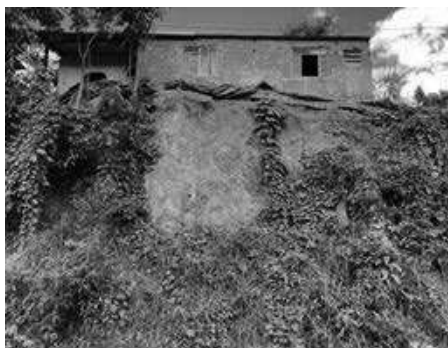
Figura 12 – Habitação em área de risco na comunidade da Portelinha
