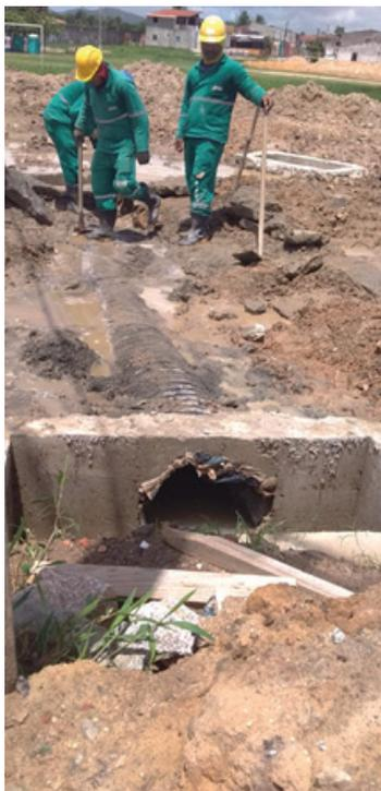
Figura 3 – Tubulação para drenagem no entorno do trecho 1 do Parque Lagoa da Viúva
