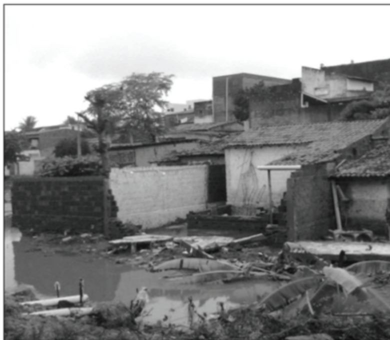
Figura 4 – Casas construídas no curso do Canal das Piabas e derrubadas pelas chuvas ocorridas no 1º semestre de 2011
