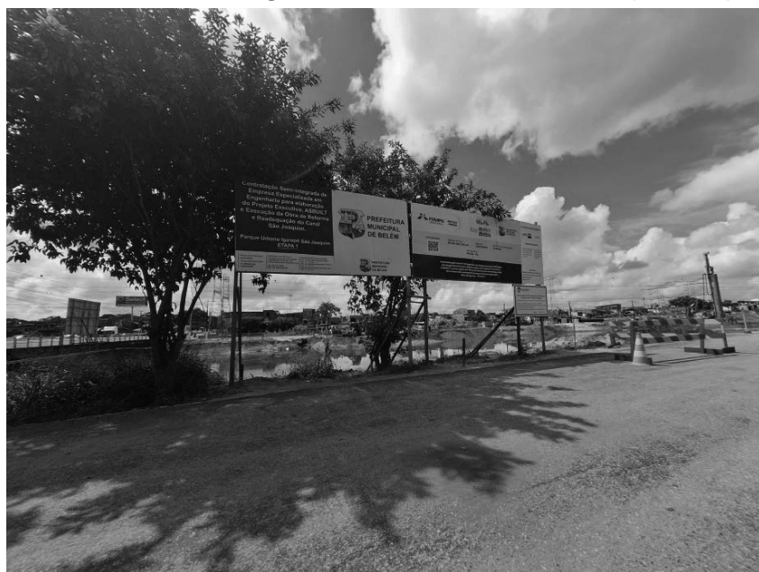
Figura 2: Parque Linear Urbano Igarapé São Joaquim em fase de execução do projeto
