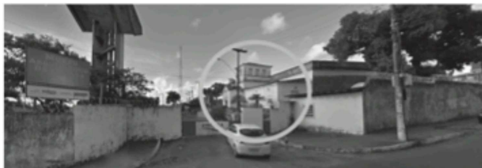
Figura 5 – À direita, circulado em amarelo, casarão neoclássico ainda existente, hoje sede do Museu Arqueológico da EMBASA; à esquerda, novo reservatório para distribuição de água em concreto
