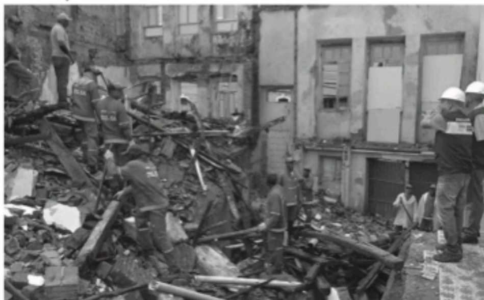
Figura 15 – Escombros de casarão que desabou na Ladeira da Soledade. Foto tirada em junho de 2019
