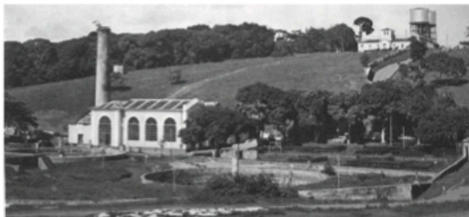
Figura 4 – Antigo casarão neoclássico junto aos reservatórios do Alto da Cruz em 1940
