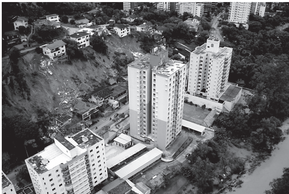
Figura 1. Deslizamento de encosta ocorrida em 2008 em área urbana de Blumenau
