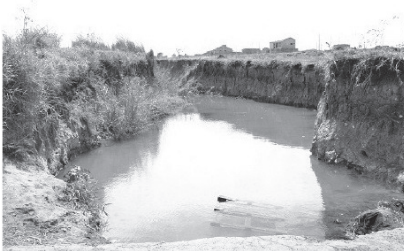
Figura 16: Inexistência de mata ciliar nas margens do córrego e lançamento de objetos
