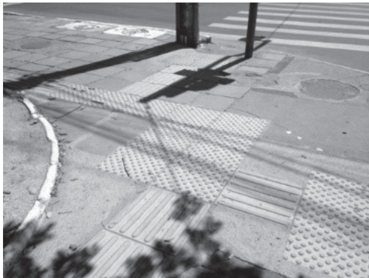
Figura 17. Piso tátil de alerta e direcional na esquina da Avenida Loureiro da Silva, em frente à Receita Federal.
