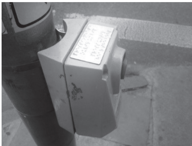
Figura 9. Dispositivo para pedestres acionarem o semáforo em altura adequada e em Braille, na Avenida Borges de Medeiros.
