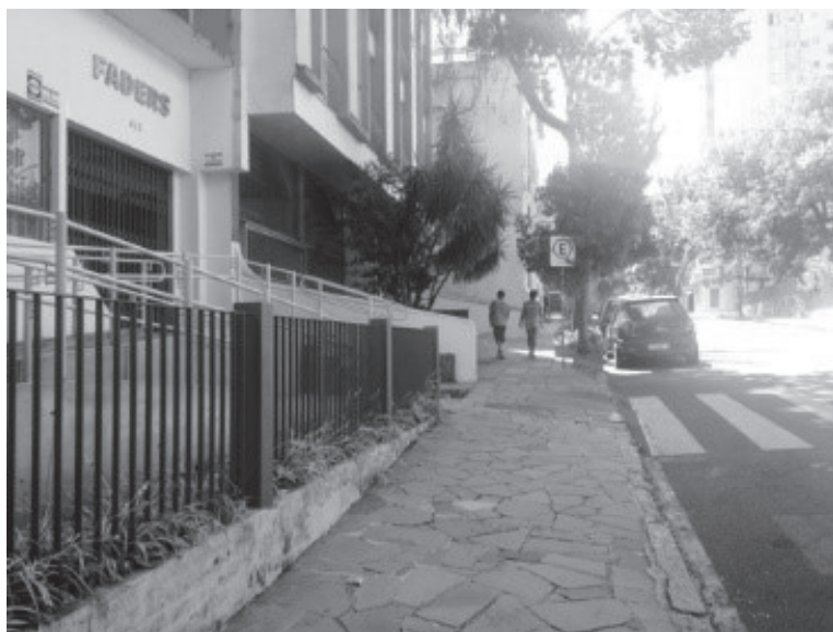
Figura 15. Em frente à FADERS, na Rua Duque de Caxias, não há recursos de acessibilidade.
