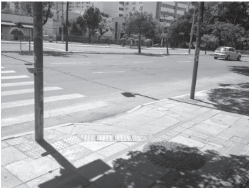
Figura 16. Piso tátil de alerta e direcional sinalizando os obstáculos e rampa sinalizada e com inclinação adequada, na Avenida Loureiro da Silva, em frente à Escola Técnica Estadual Parobé.
